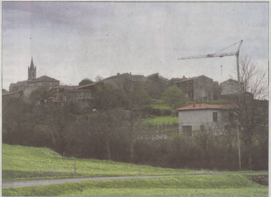
■ De nouvelles constructions s'érigent dans les hameaux.
