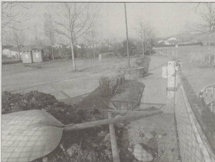
■ Des travaux sont en cours afin d'assurer la sécurité des automobilistes.
