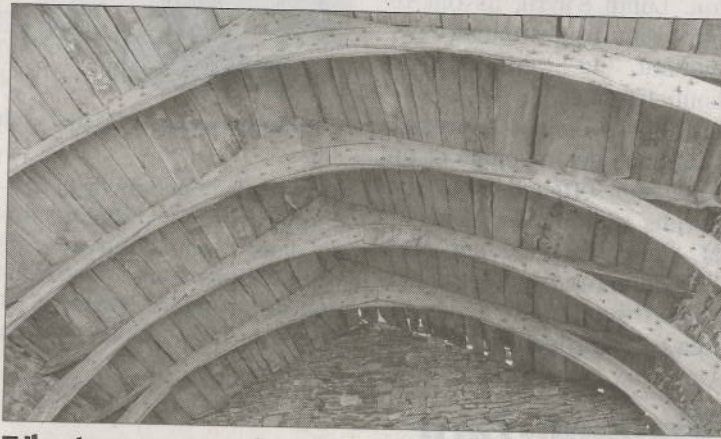
■ Il reste encore une petite partie de la charpente.
