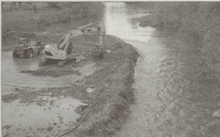
■ La montée des eaux a gêné les travaux d'assainissement en avril.
