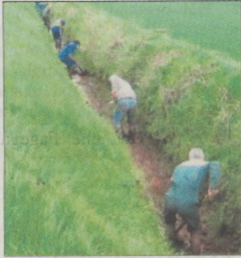
■ Opération curage du canal.
